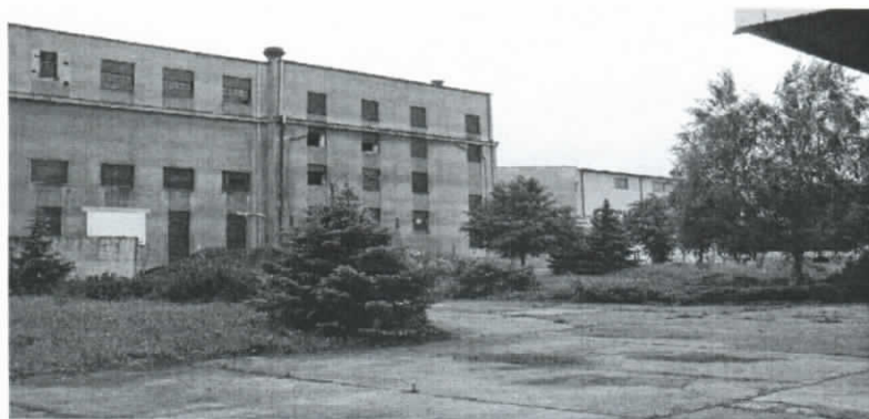
Fot. 4. Kotłownia w zespole cukrowni
