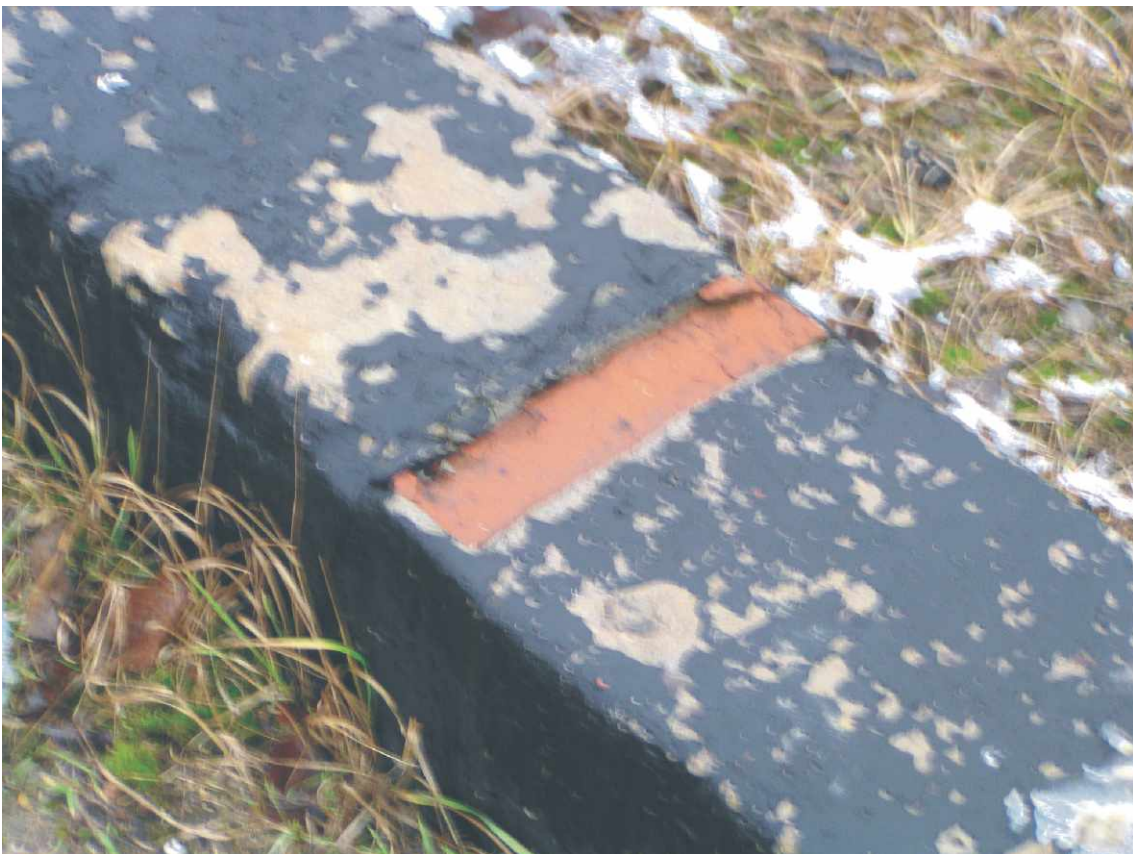
Fot. nr 44. Fragment wykonany z cegły pełnej ceramicznej - miejsce wykonania patrz rys. nr 1.
