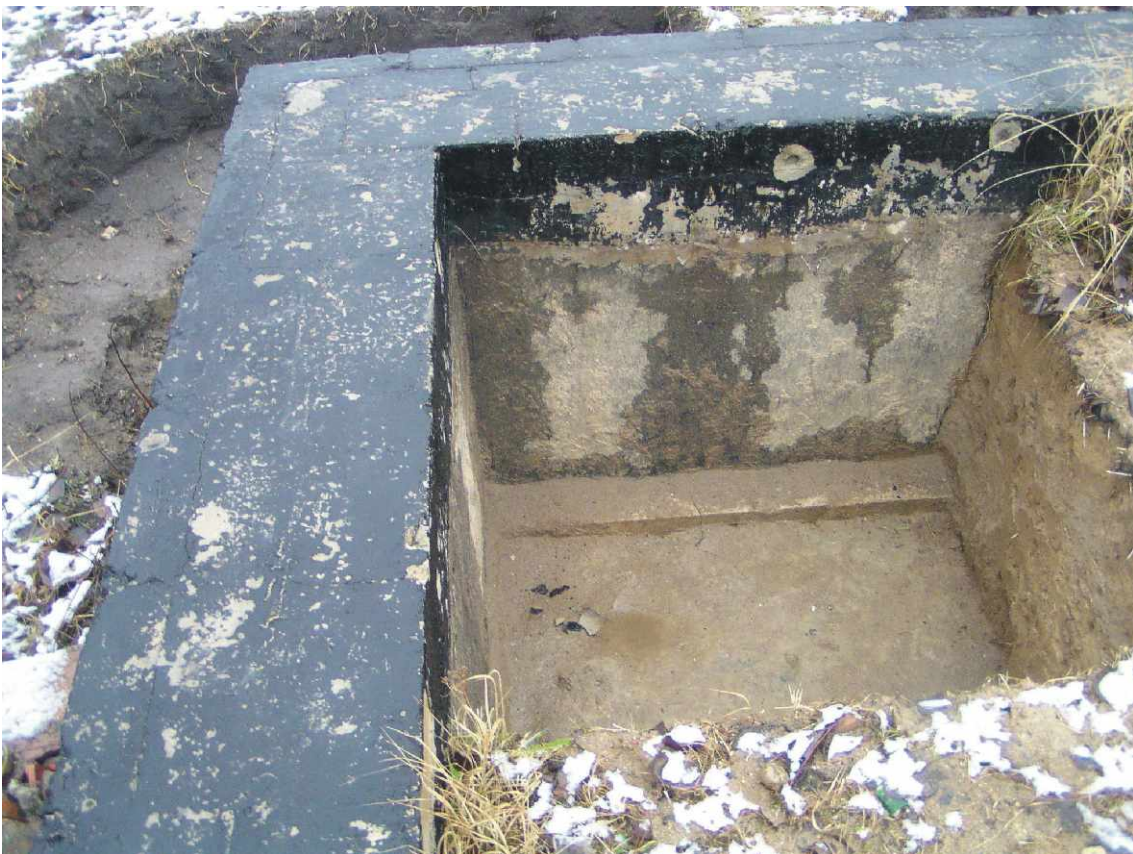
Fot. nr 28. Odkrywka nr 8a - miejsce wykonania patrz rys. nr 1.
