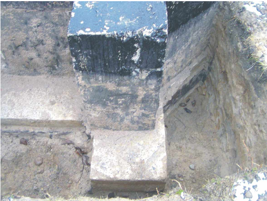
Fot. nr 36. Odkrywka nr 10c - miejsce wykonania patrz rys. nr 1.
