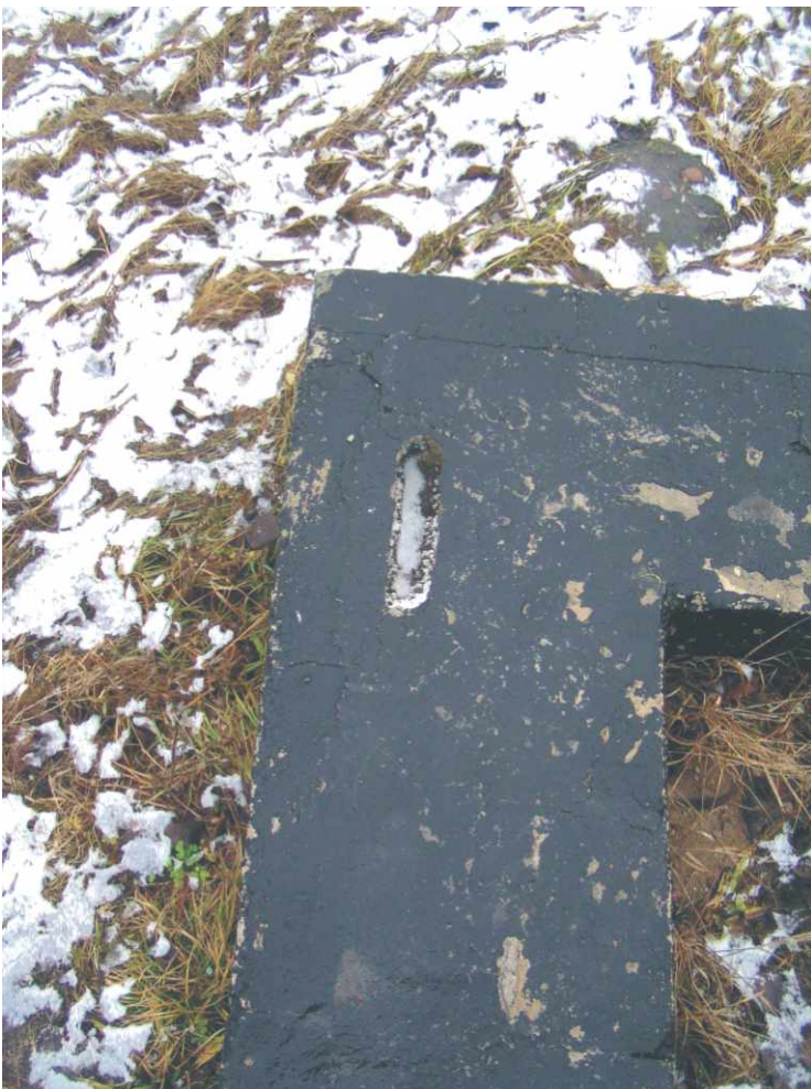
Fot. nr 38. Odkrywka z widoczną izolacją termiczną - miejsce wykonania patrz rys. nr 1.
