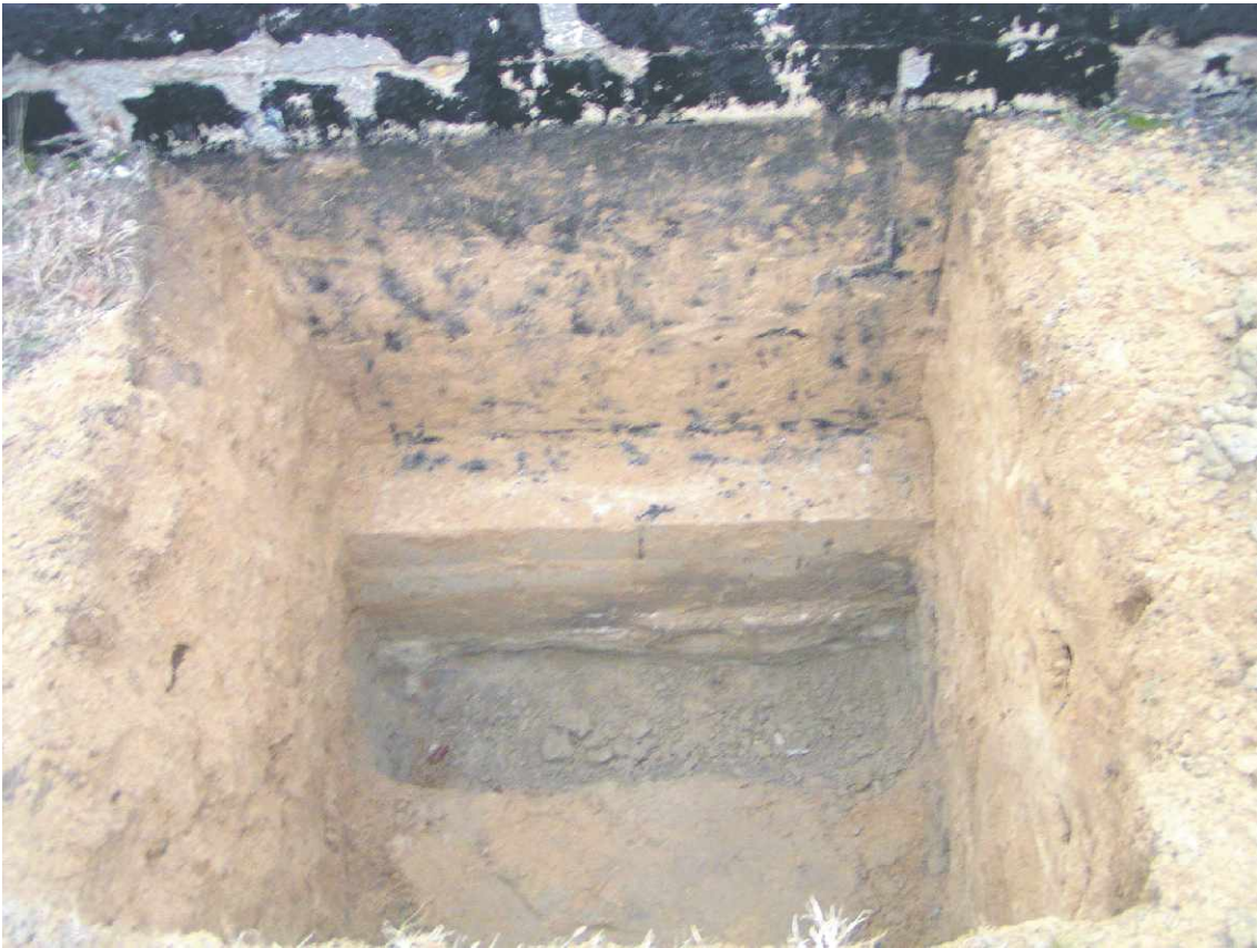
Fot. nr 15. Odkrywka nr 3a - miejsce wykonania patrz rys. nr 1.
