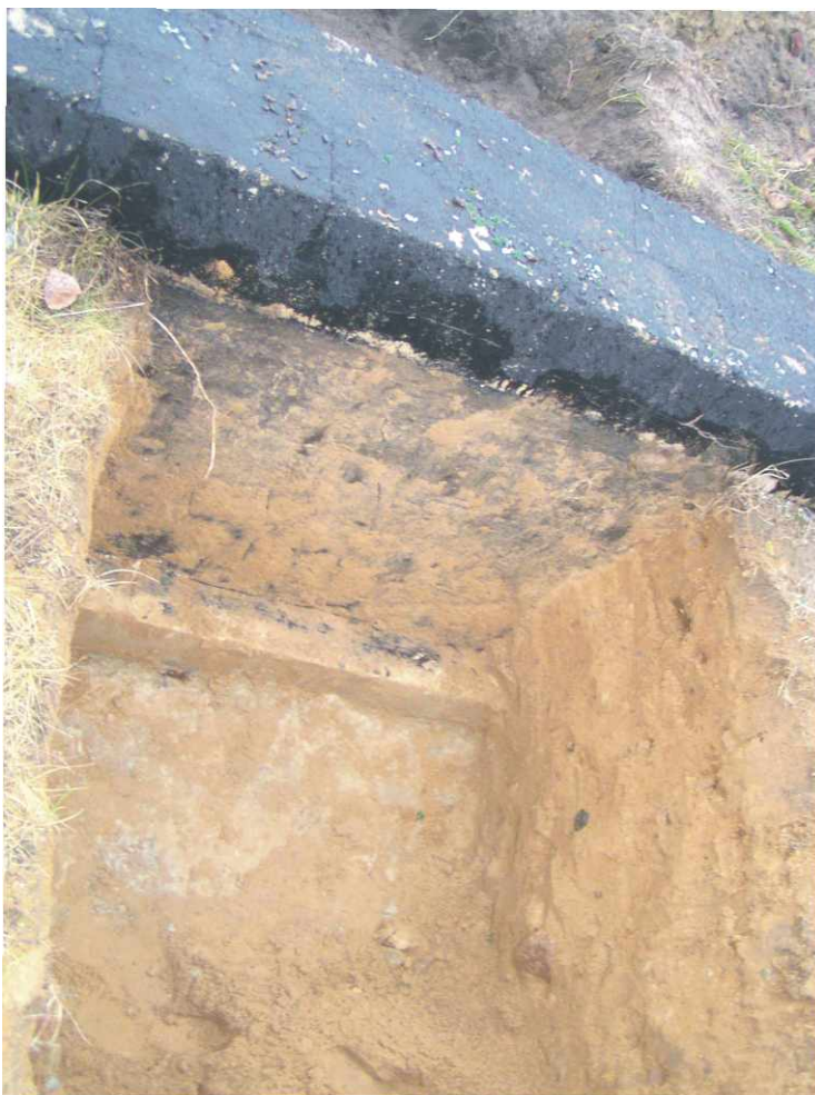
Fot. nr 20. Odkrywka nr 5a - miejsce wykonania patrz rys. nr 1.
