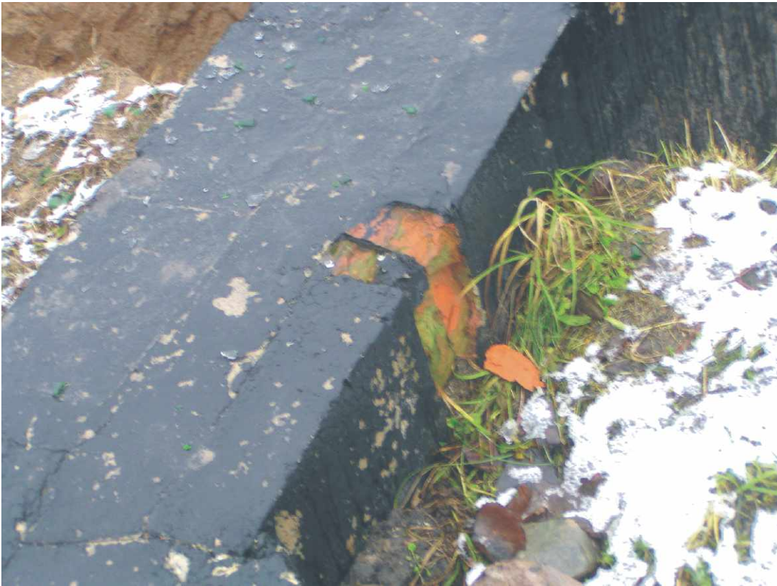
Fot. nr 47. Fragment wykonany z cegły pełnej ceramicznej - miejsce wykonania patrz rys. nr 1.
