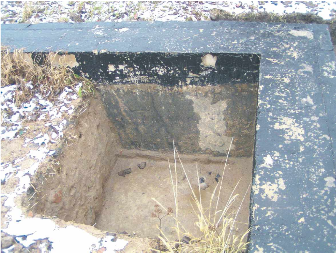
Fot. nr 29. Odkrywka nr 8a - miejsce wykonania patrz rys. nr 1.
