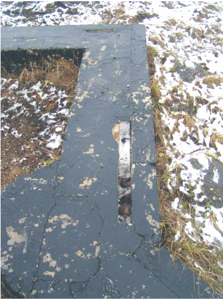
Fot. nr 37. Odkrywka z widoczną izolacją termiczną - miejsce wykonania patrz rys. nr 1.
