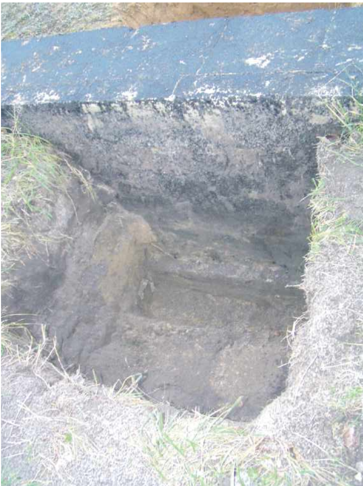
Fot. nr 13. Odkrywka nr 2a - miejsce wykonania patrz rys. nr 1.
