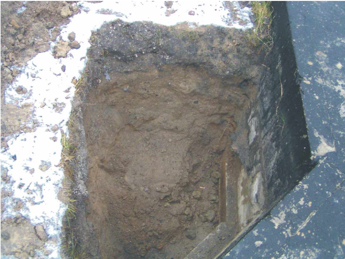
Fot. nr 25. Odkrywka nr 7a - miejsce wykonania patrz rys. nr 1.
