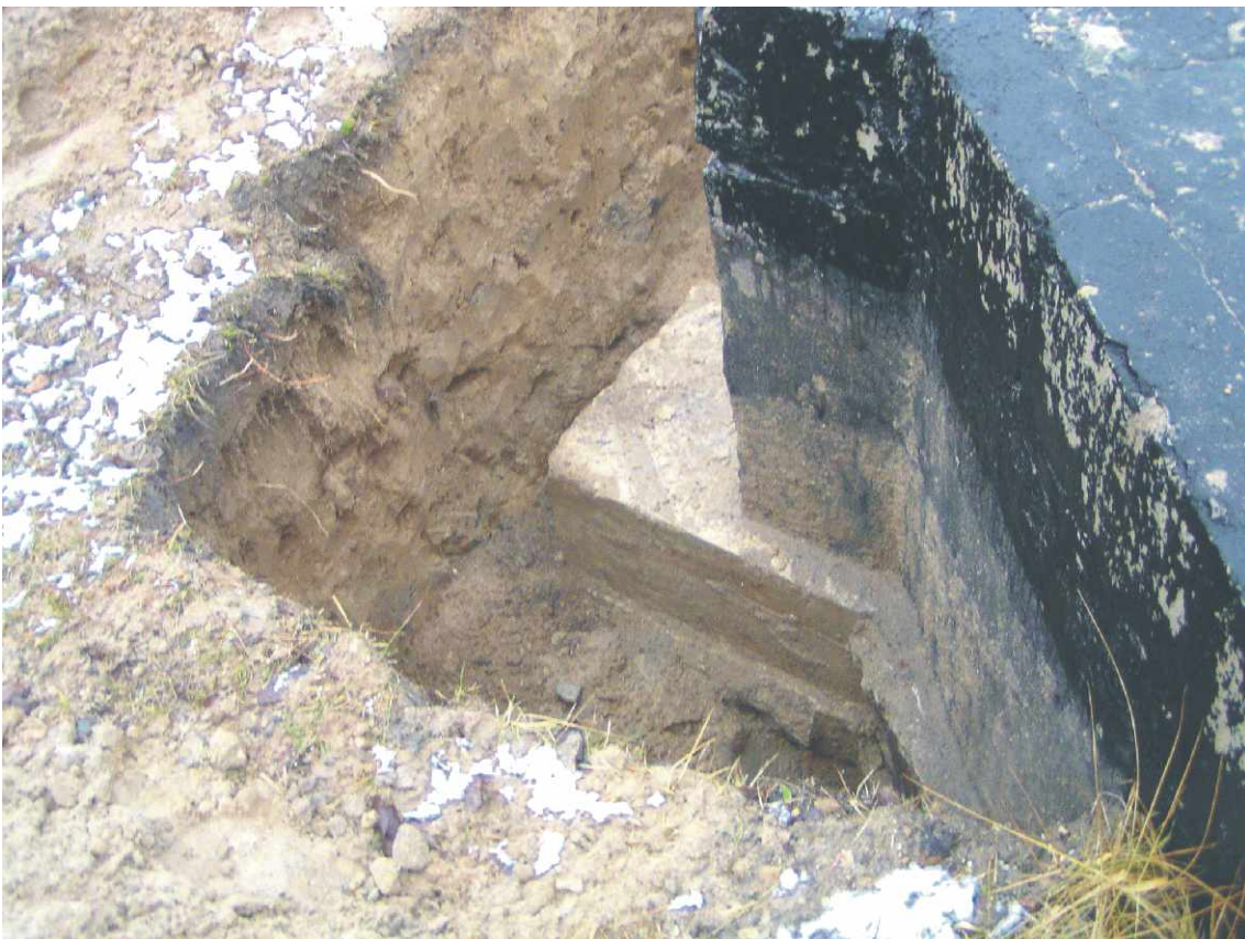
Fot. nr 34. Odkrywka nr 10a - miejsce wykonania patrz rys. nr 1.
