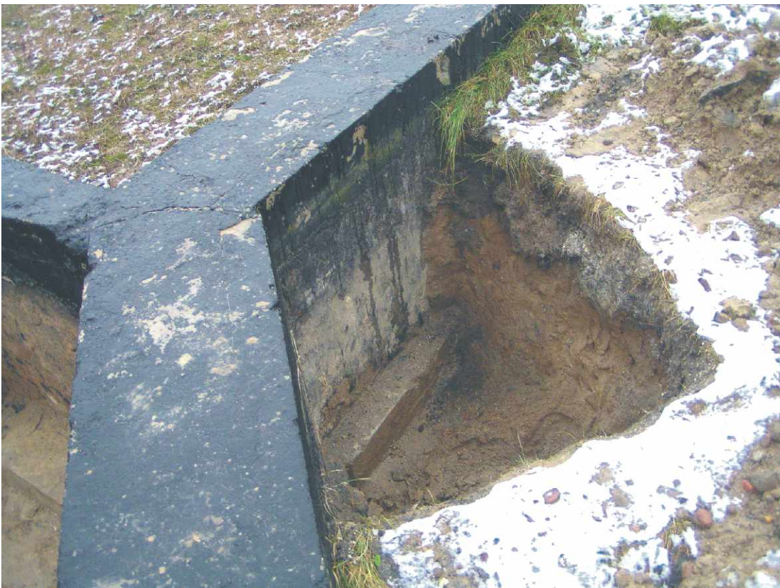
Fot. nr 24. Odkrywka nr 7 - miejsce wykonania patrz rys. nr 1.
