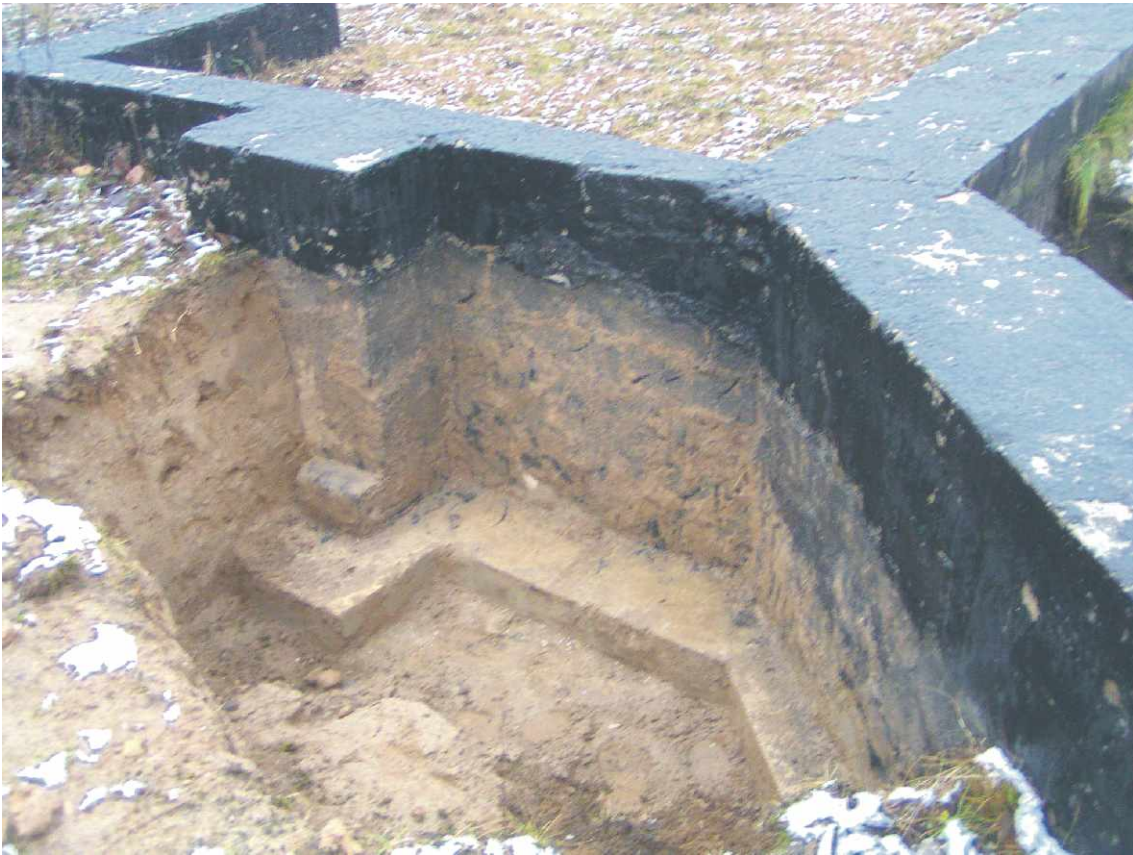
Fot. nr 29. Odkrywka nr 7c - miejsce wykonania patrz rys. nr 1.
