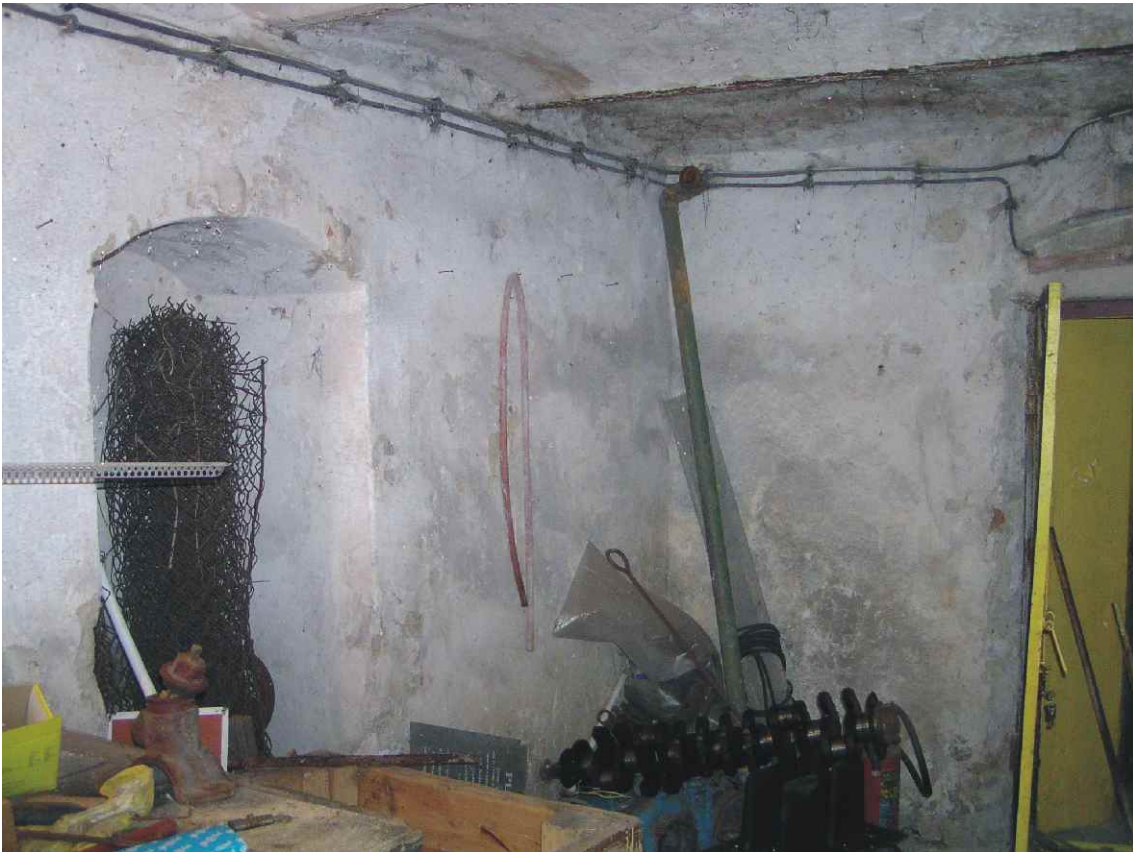
Fot. nr 49. Wnęka w pomieszczeniu piwnicy.
