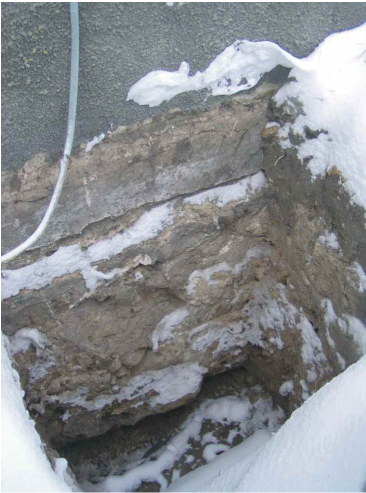
Fot. nr 23. Odkrywka fundamentów.
