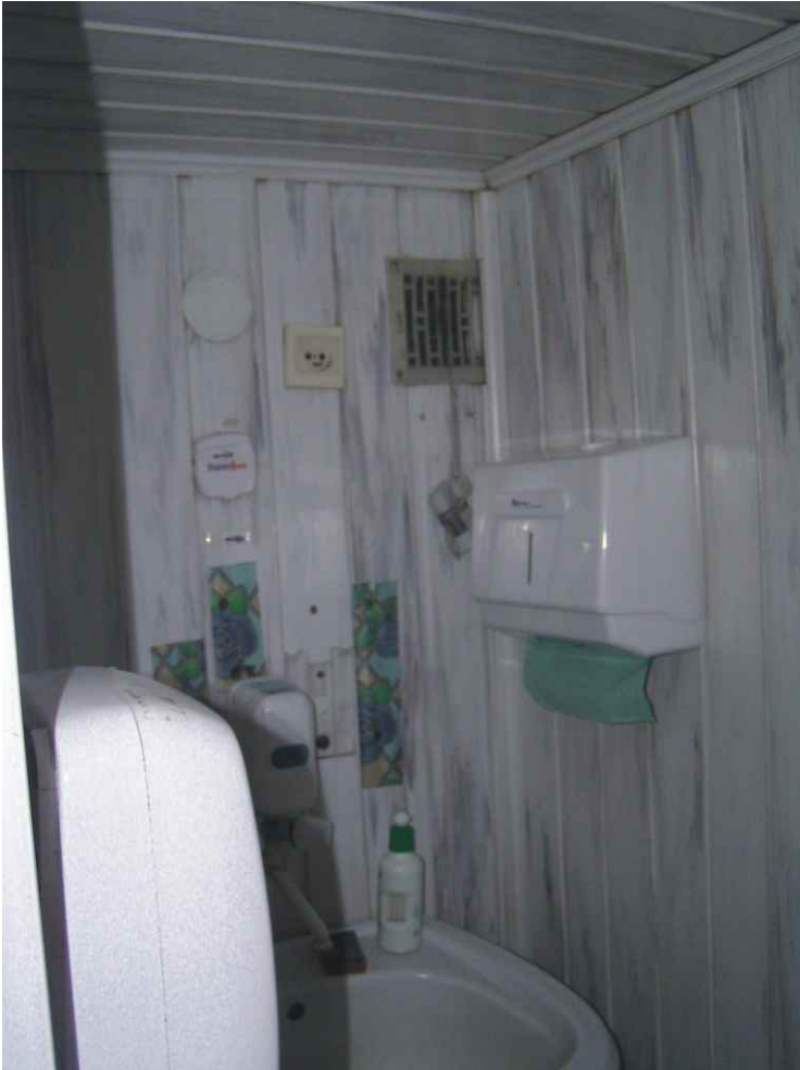
Fot. nr 33. Sanitariat - parter.
