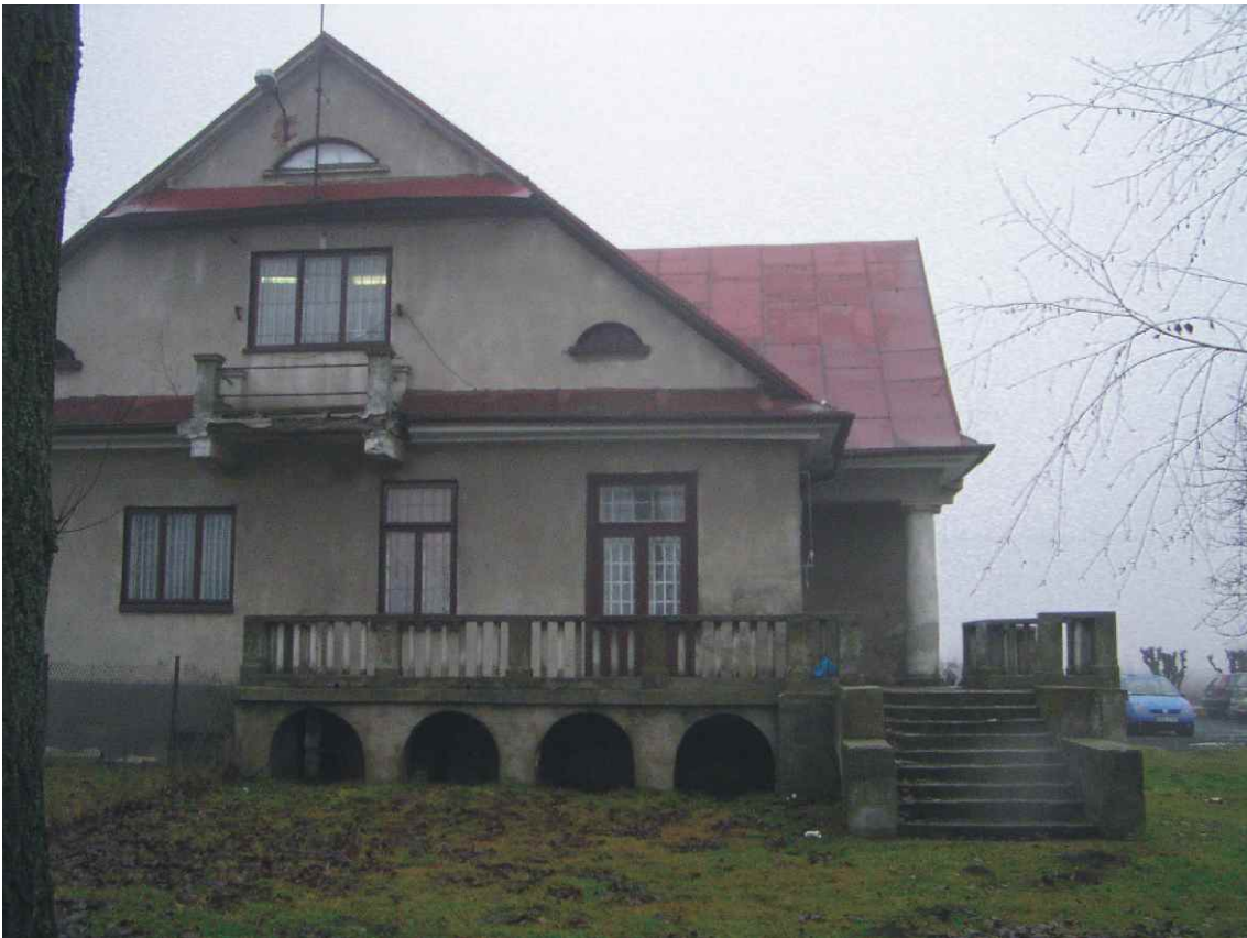
Fot. nr 8. Fragment zachodni elewacji północnej.
