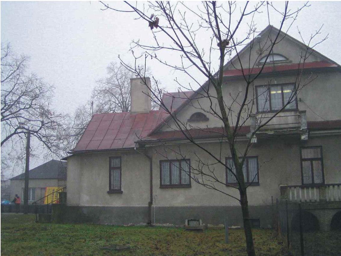
Fot. nr 7. Fragment wschodni elewacji północnej.
