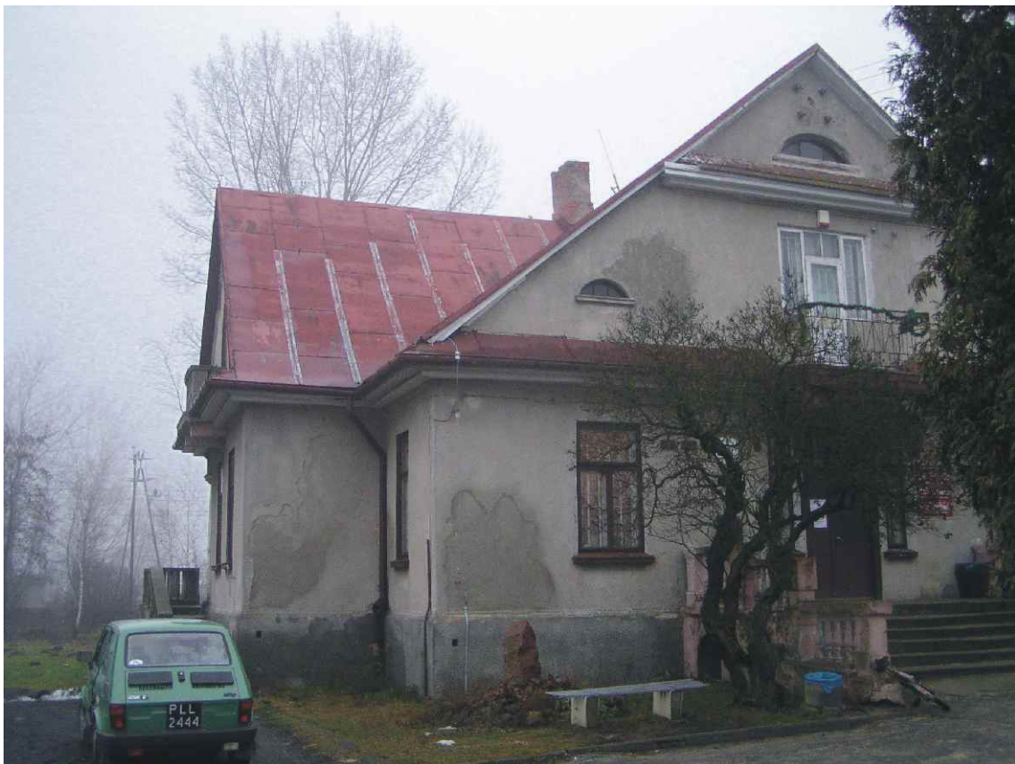
Fot. nr 4. Widok na część zachodnią od strony drogi.
