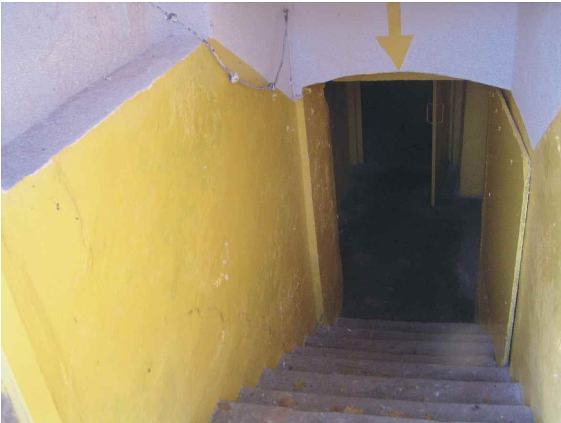
Fot. nr 44. Zejście do piwnicy.
