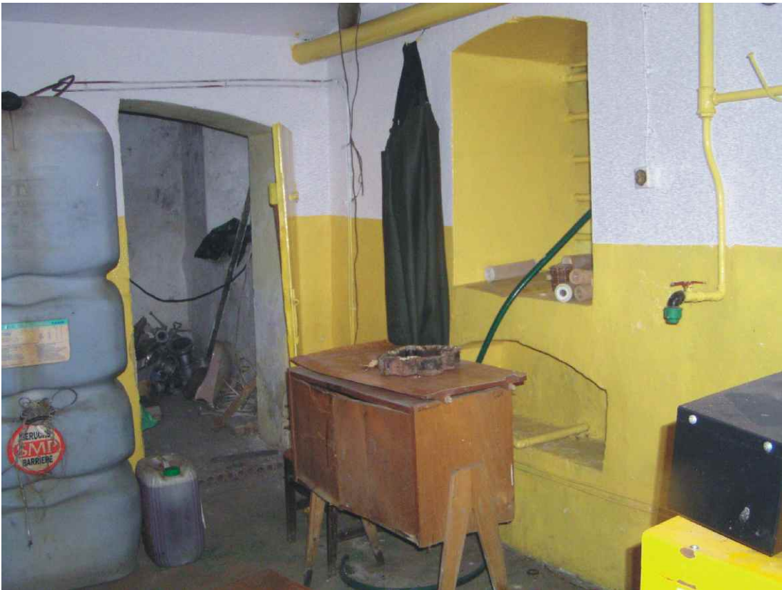
Fot. nr 50. Fragment kotłowni - zamurowany w części otwór drzwiowy, okienko, wnęka.
