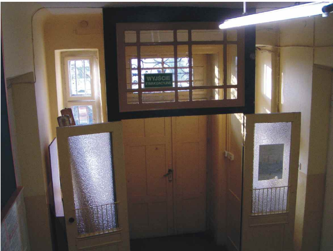
Fot. nr 24. Wejście do budynku.
