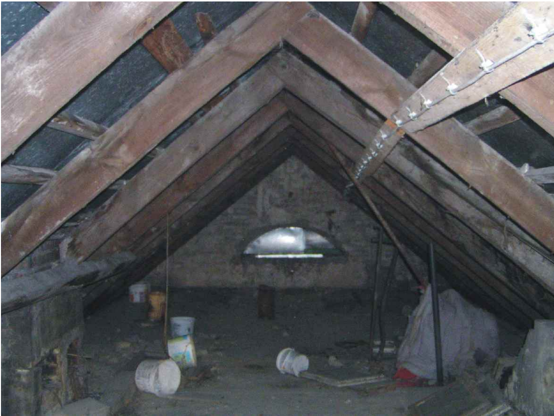
Fot. nr 51. Widok ogólny poddasza.
