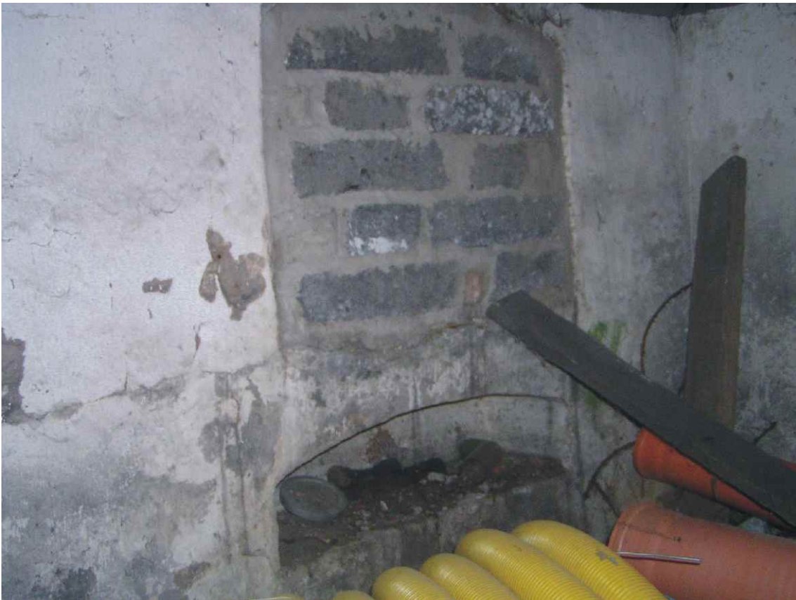
Fot. nr 48. Zamurowane okienko piwnicy.
