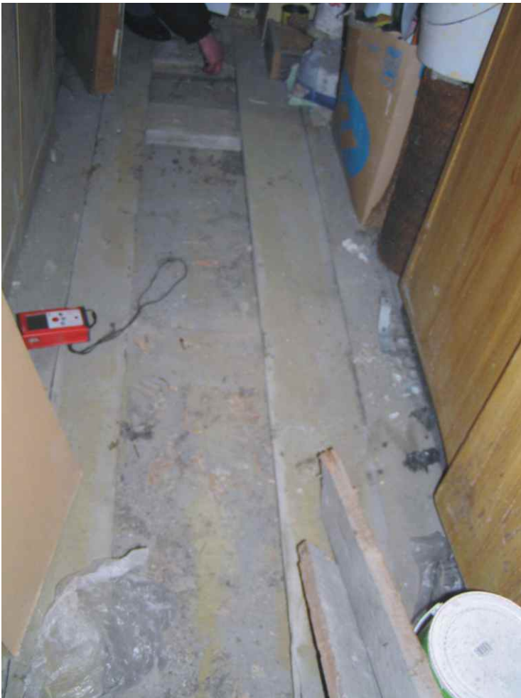
Fot. nr 32. Odsłonięty układ belek nad parterem.
