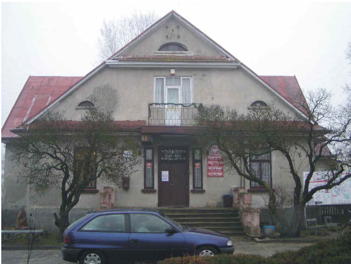
Fot. nr 2. Elewacja frontowa.
