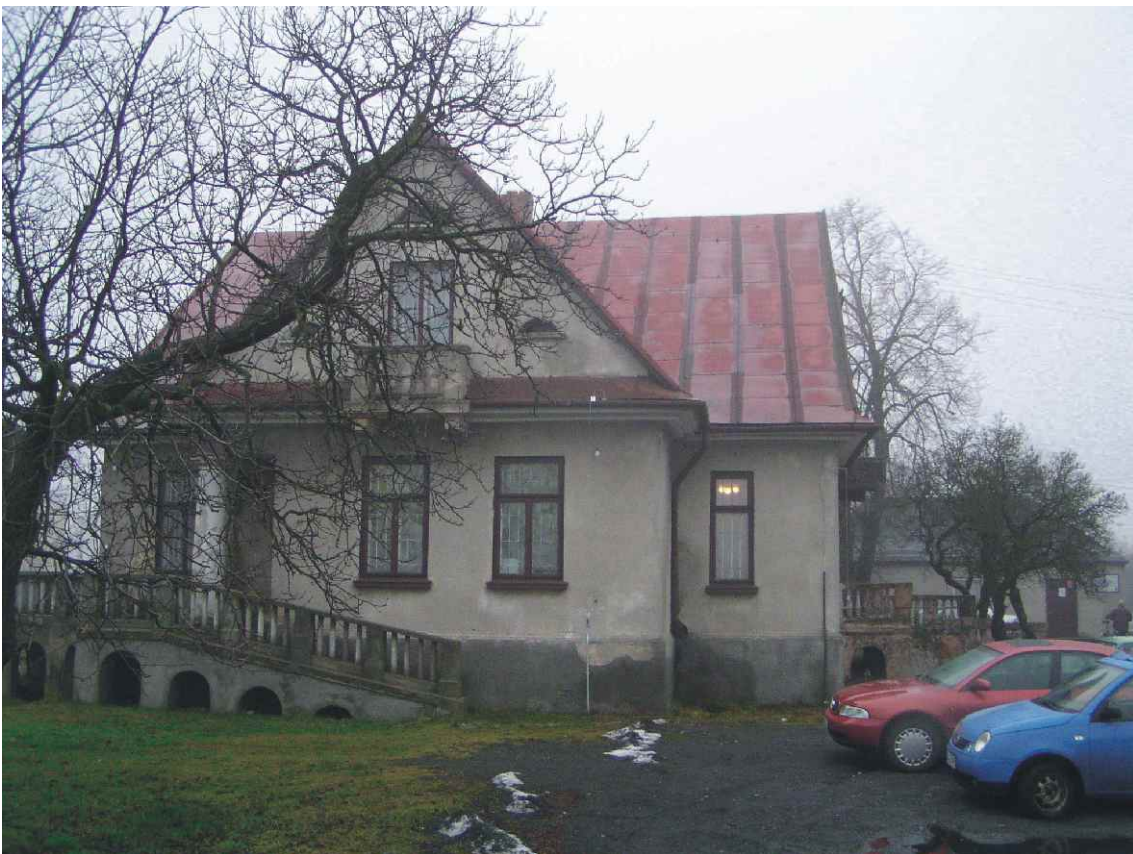
Fot. nr 10. Elewacja zachodnia.
