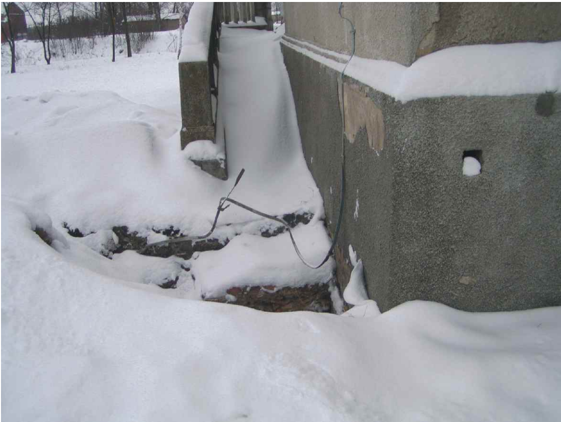
Fot. nr 22. Miejsce odkrywki fundamentów.
