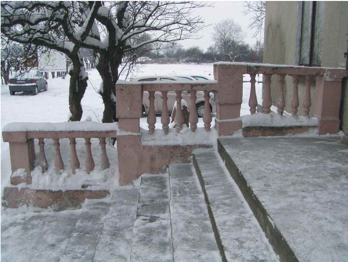
Fot. nr 13. Balustrada wejścia głównego.
