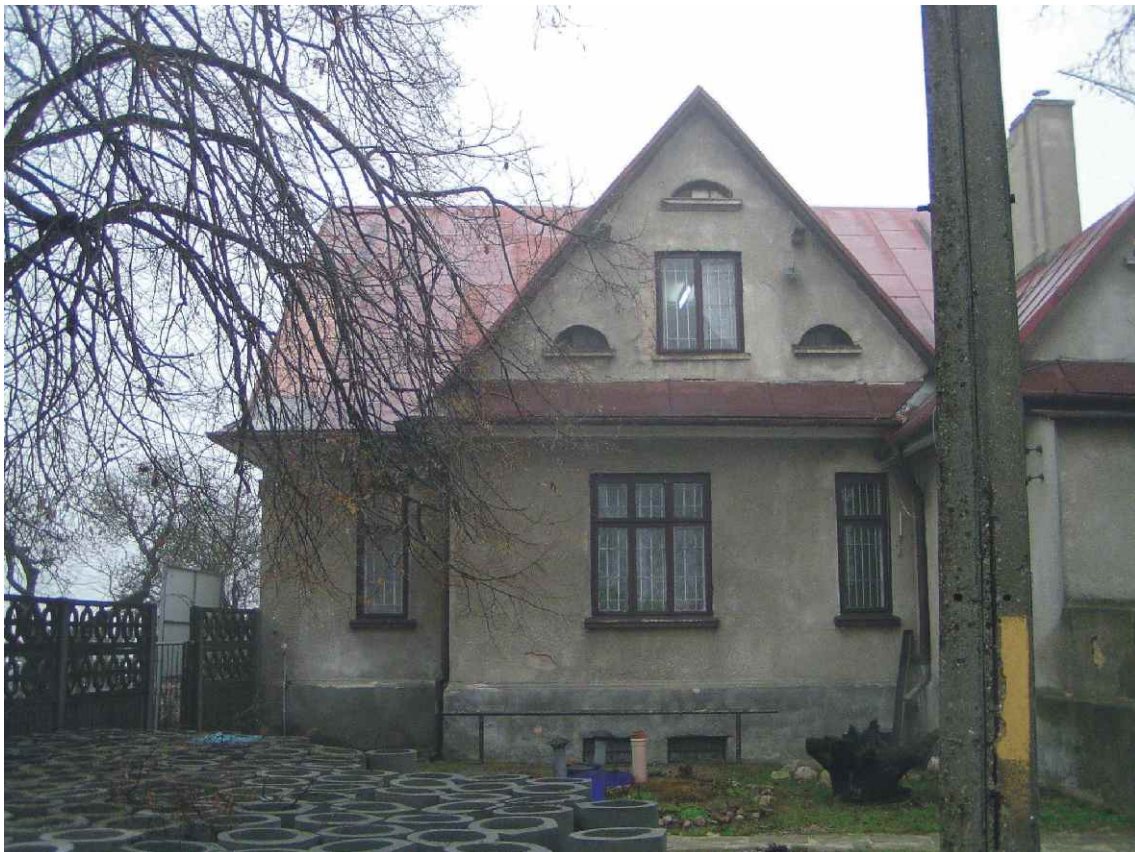
Fot. nr 5. Fragment południowy elewacji wschodniej.
