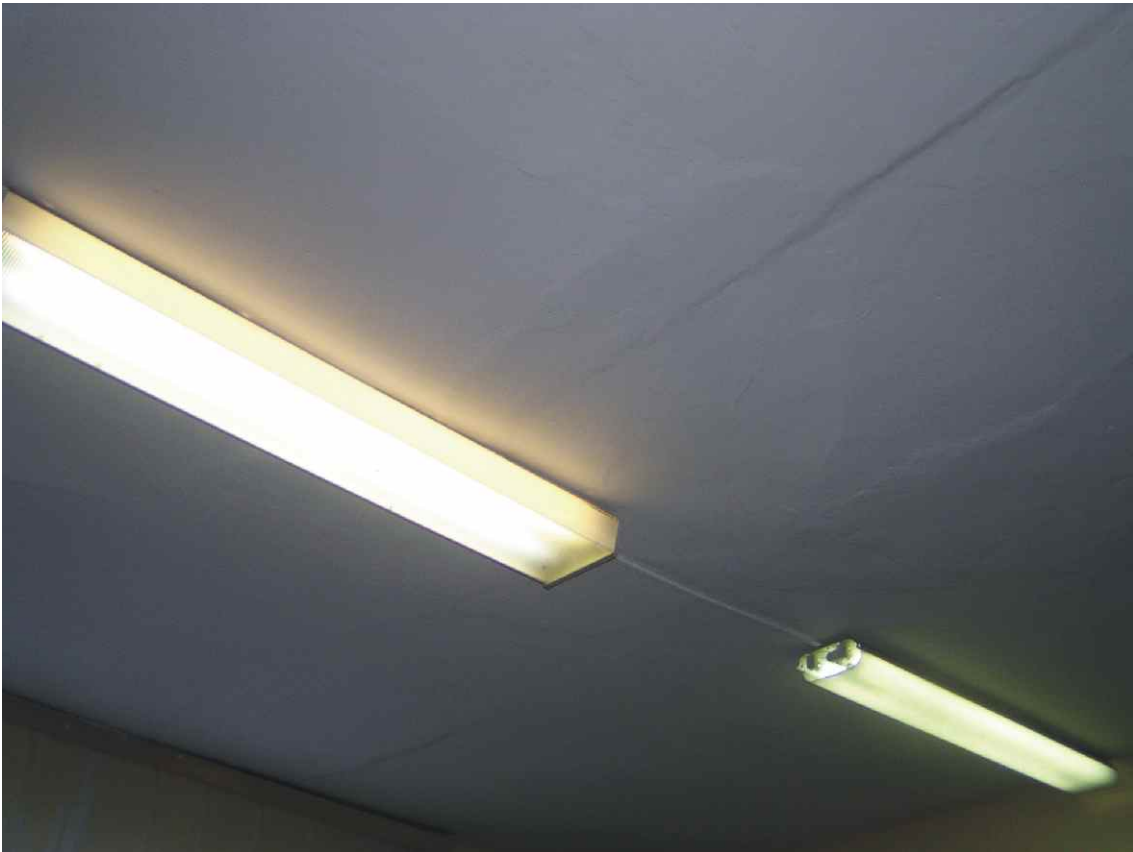
Fot. nr 43. Naprawa sufitu poddasza.
