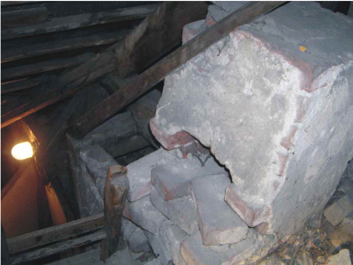
Fot. nr 59. Wieżba dachowa i zamurowany komin.
