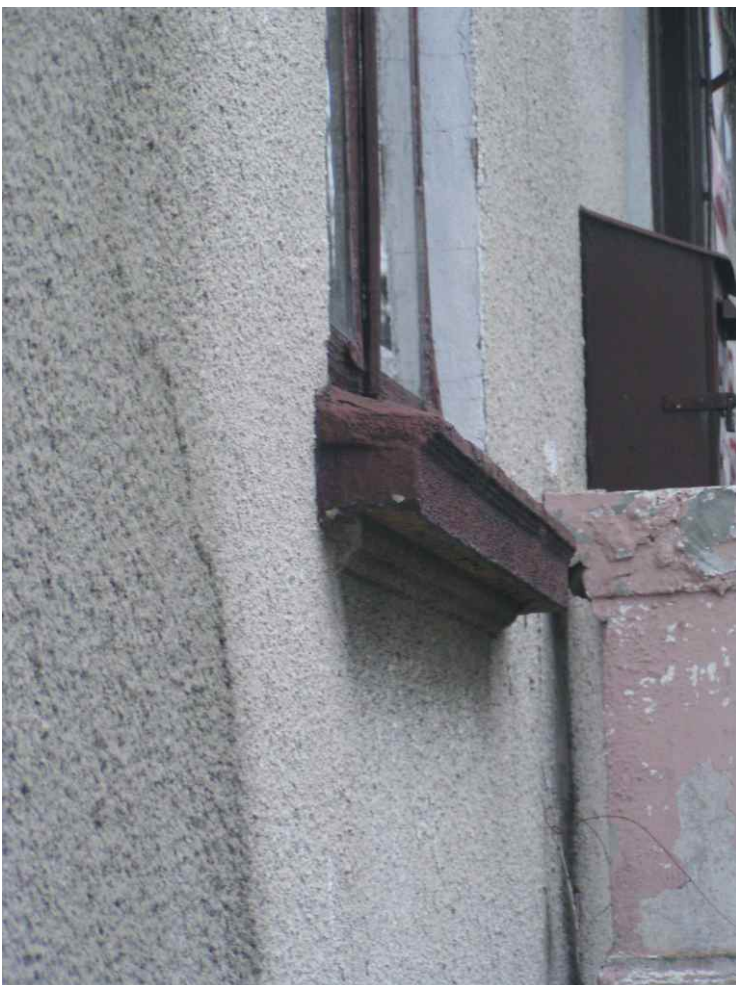
Fot. nr 20. Widok na parapet podokienny.
