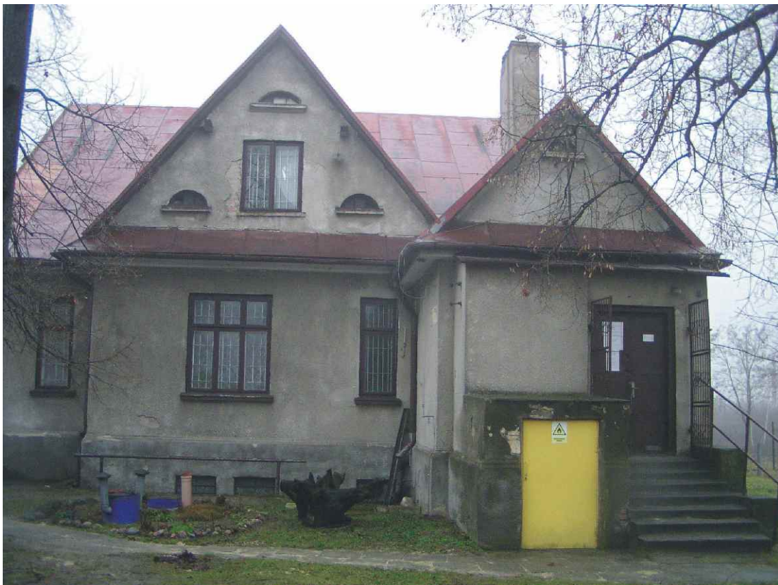
Fot. nr 6. Fragment północny elewacji wschodniej.
