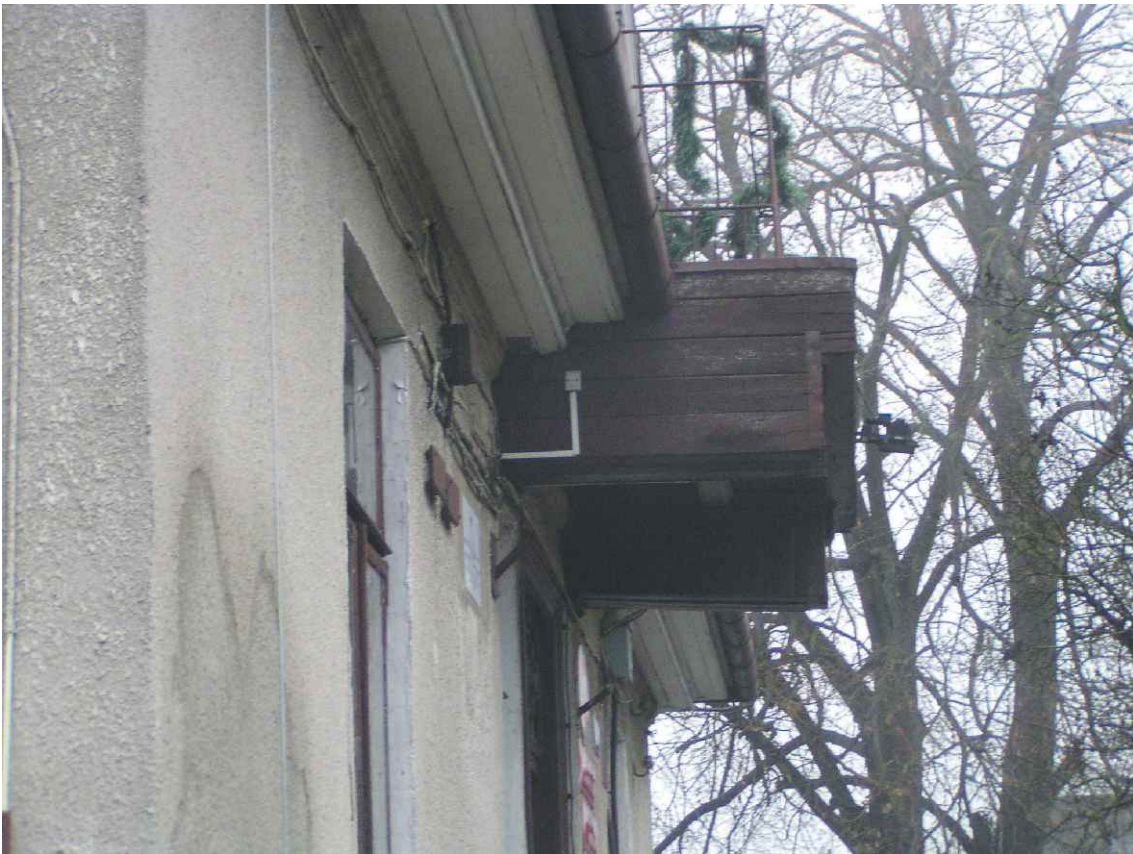
Fot. nr 14. Balkon wschodni.
