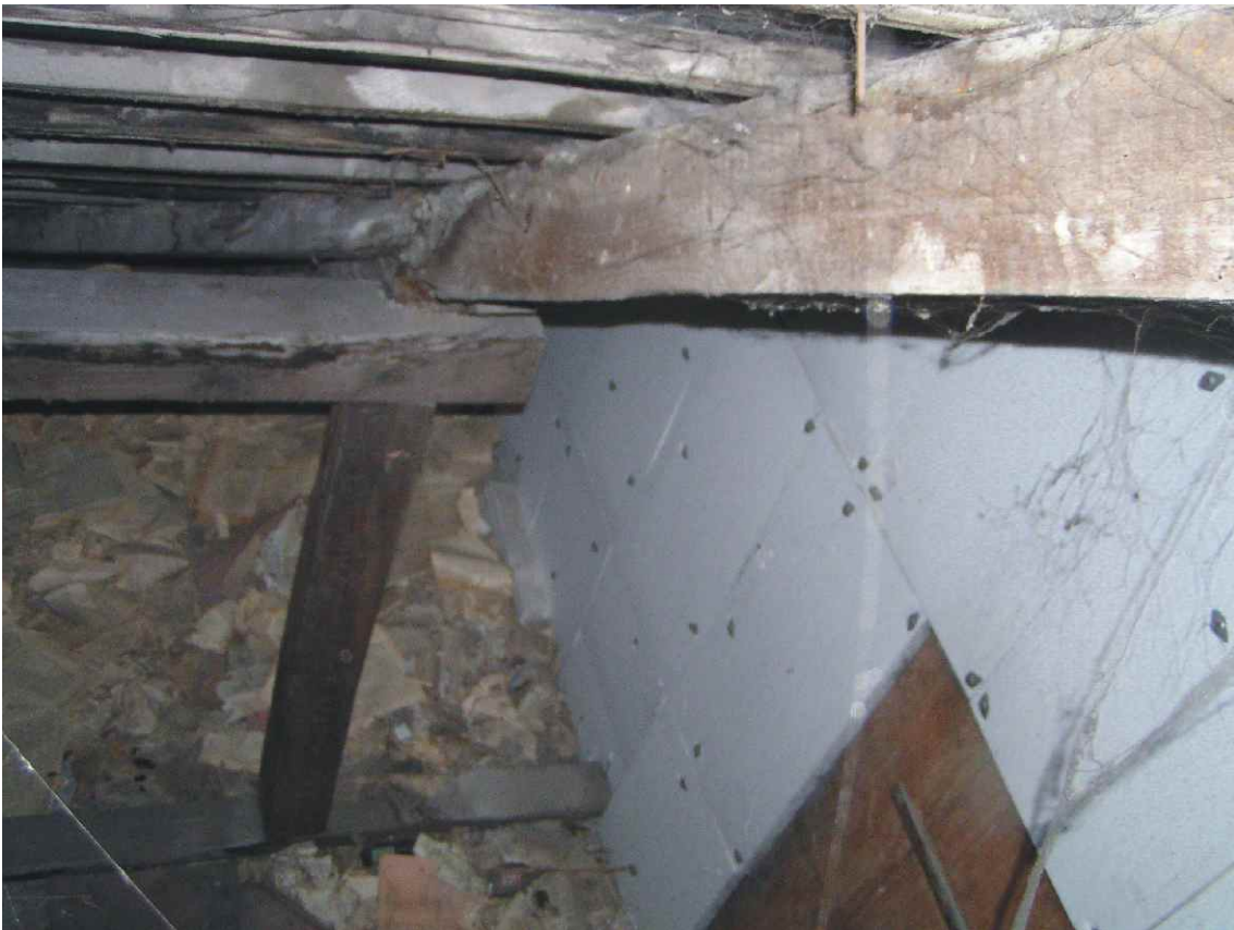
Fot. nr 58. Widok z góry na niedostępne poddasze - widoczny otwór drzwiowy.
