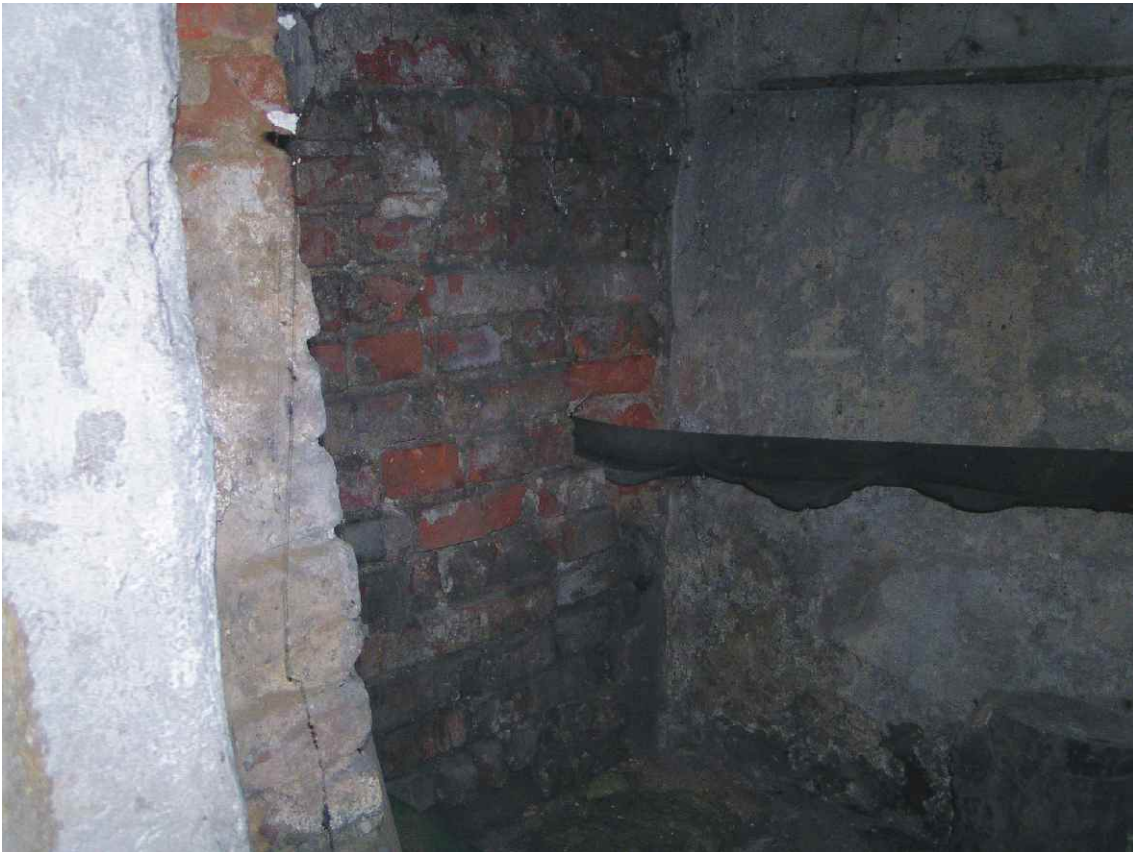
Fot. nr 45. Fragment piwnicy.
