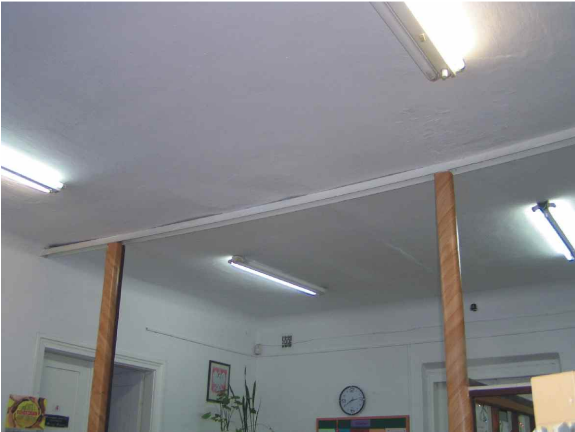
Fot. nr 39. Belka stalowa podpierająca strop i słupki - widoczne uwięcie.
