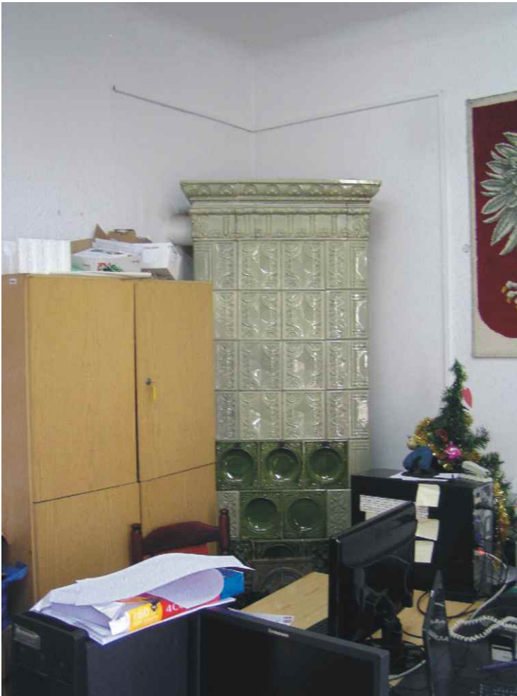
Fot. nr 35. Zachowany piec kaflowy - poddasze.
