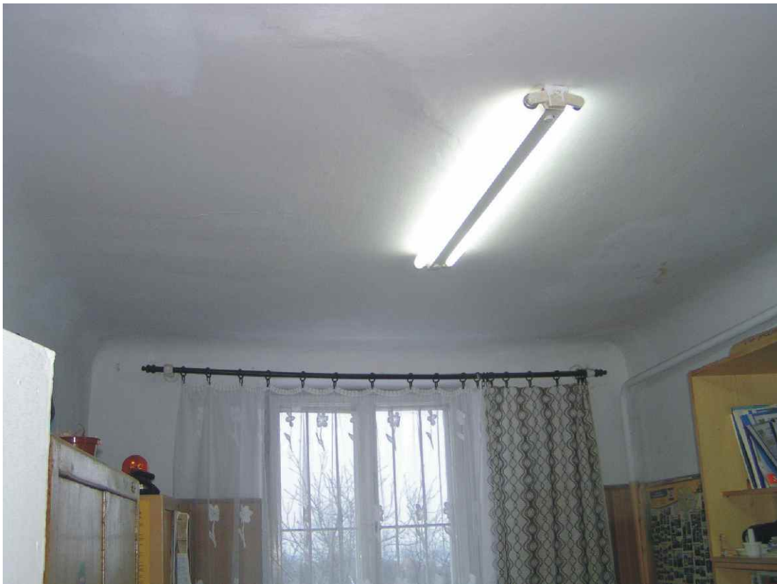
Fot. nr 41. Pokój biurowy, poddasze - ugięcie stropu.
