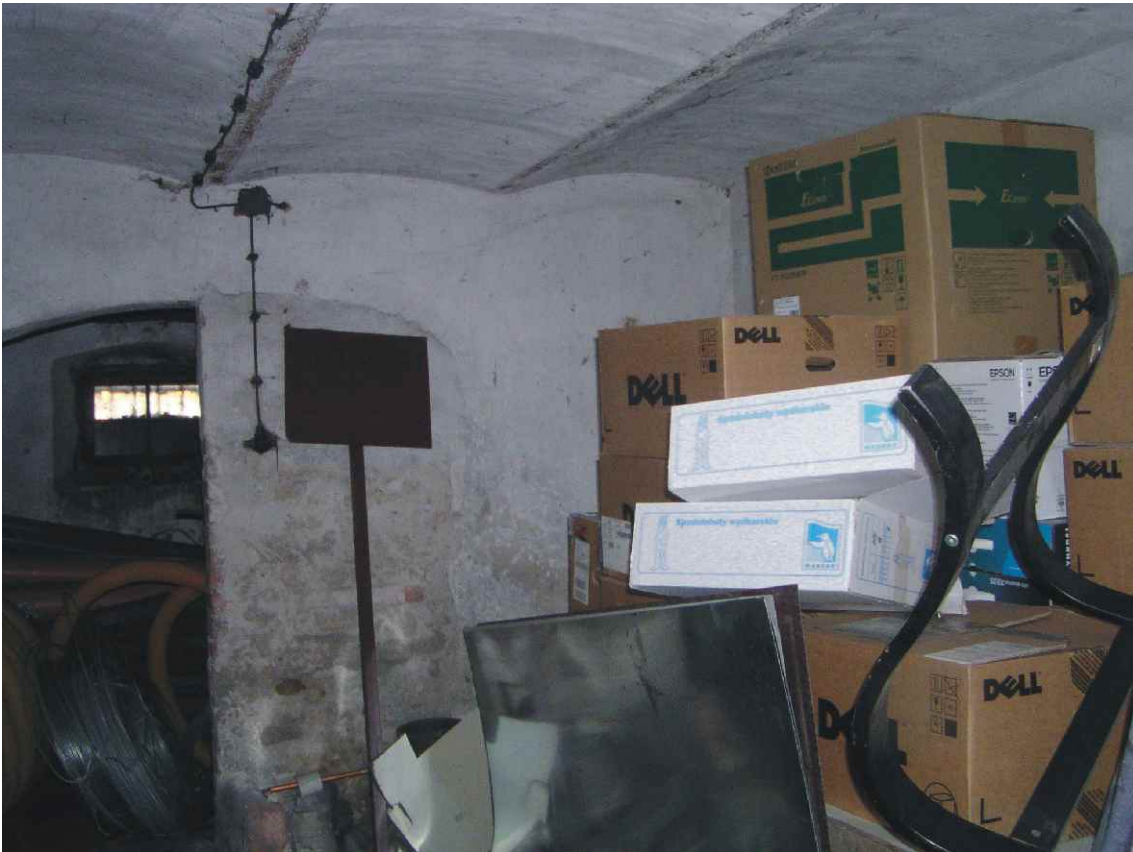
Fot. nr 47. Piwnica, strop - częściowo zamurowany otwór.
